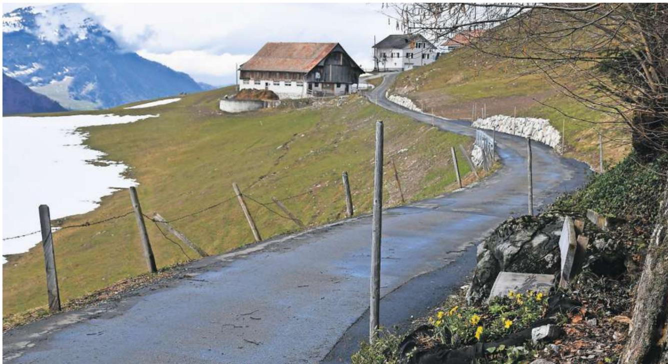
Die Bergstrasse ist in einem schlechten Zustand. Einige Trockenmauern wurden bereits neu erstellt, wie hier im Bürisberg. Nun folgt die Fahrbahnsanierung.
